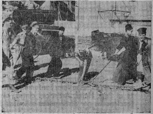
COOPERACION ANGLO-FRANCESA.—Marineros ingleses y obreros franceses trabajan juntos para realizar las reparaciones que son necesarias después de cesar el fuego en Mers-el-Kebir, al noroeste de Orán.
